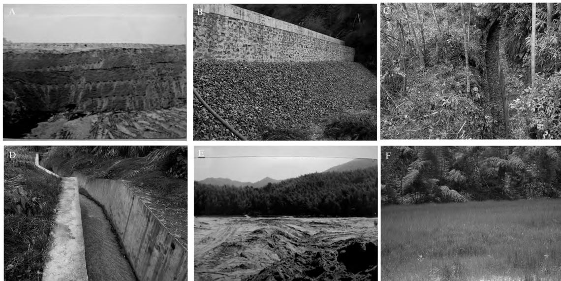
A—削坡施工的第一子坝; B—建成的基本坝; C—尾矿库东面排水沟; D—尾矿库西面排水沟;
